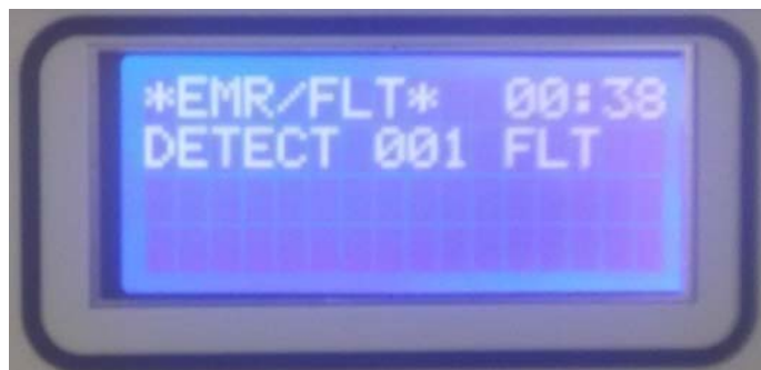
Fig. 3-6) Videata in stato di Guasto
